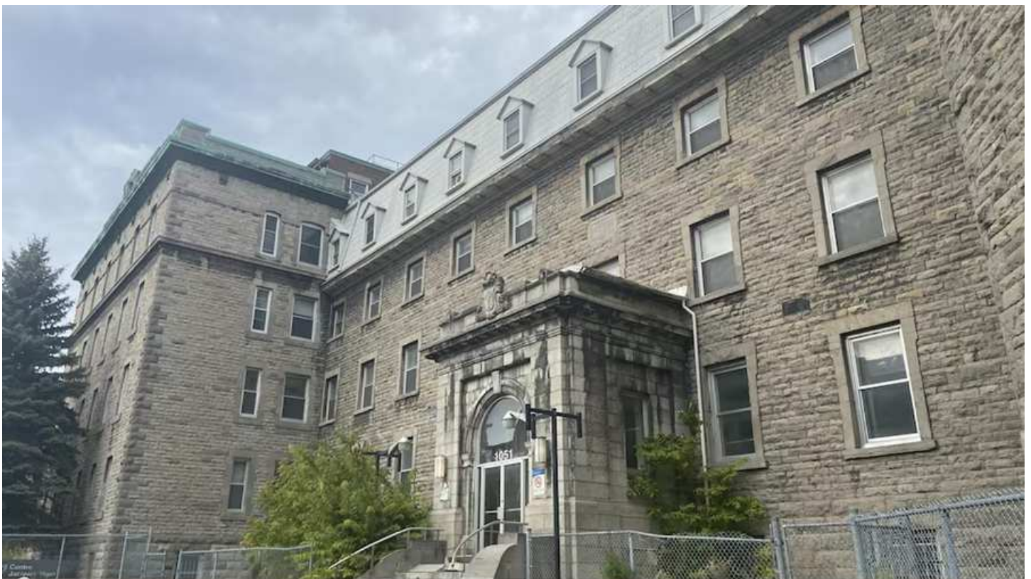
Les bâtiments de l'ancien hôpital de la Miséricorde, sur le boulevard René-Lévesque, à Montréal, sont inoccupés depuis près de 10 ans. - PHOTO : Radio-Canada / Philippe-Antoine Saulnier
